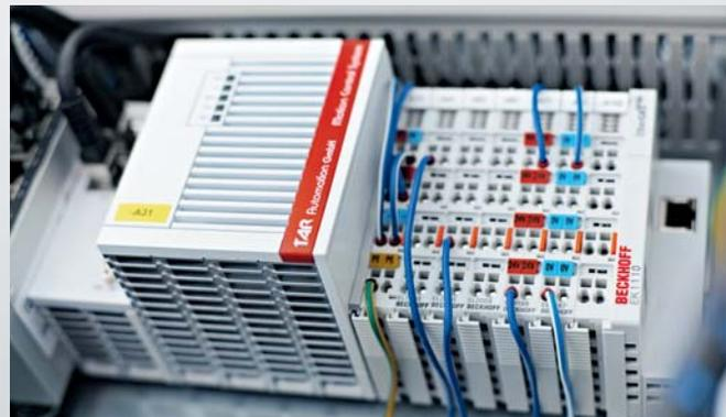
Das Condition-Monitoring-System wird komplett betriebsbereit in einem kompakten Klemmkasten geliefert und installiert.
